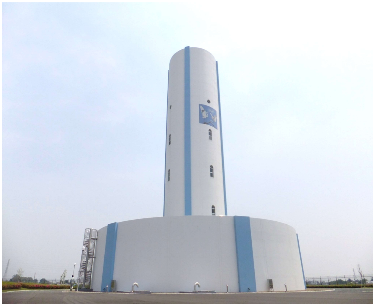
しらさぎ配水場
