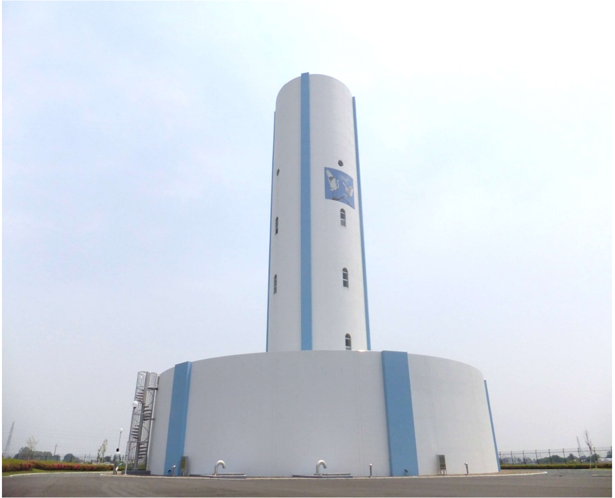
しらさぎ配水場
