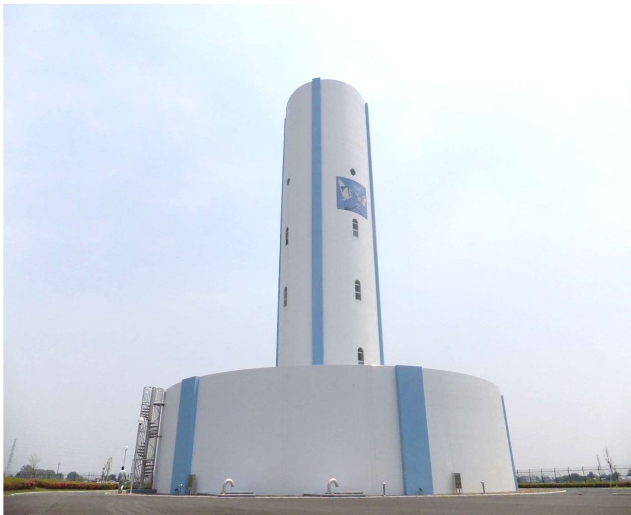
しらさぎ配水場
