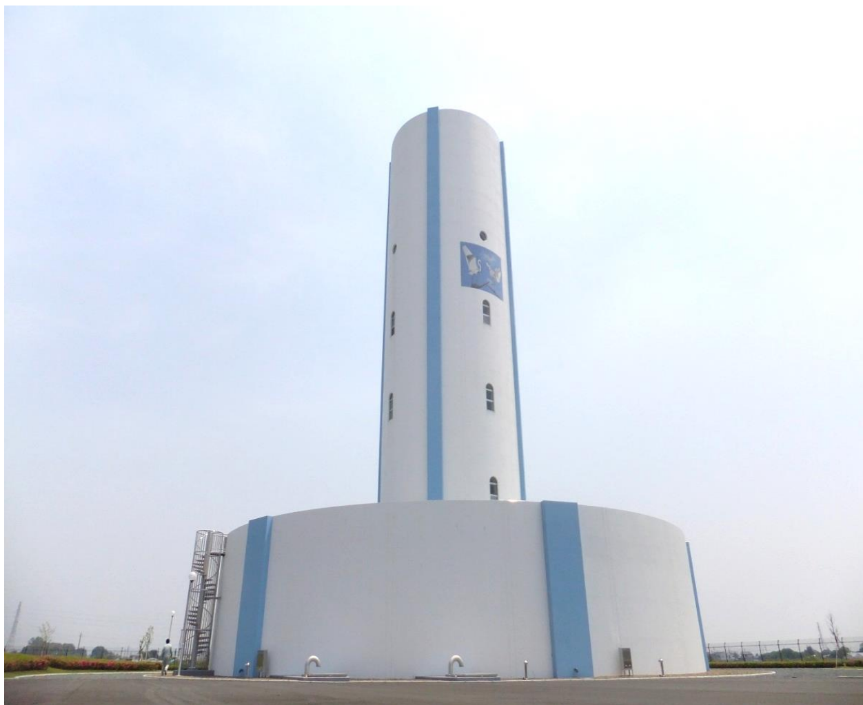
しらすぎ配水場
