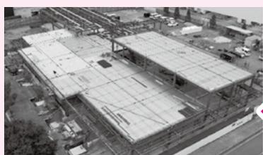
9月には、工場で作成した鉄骨を、現場に搬入して建てていく、鉄骨建方工事が行われました。
