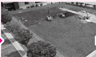
5月には、建設地に仮囲いを設置しました。まずは、基礎工事として建物が傾いたり沈んだりしないよう、地盤補強のための柱状改良工事を行いました。
