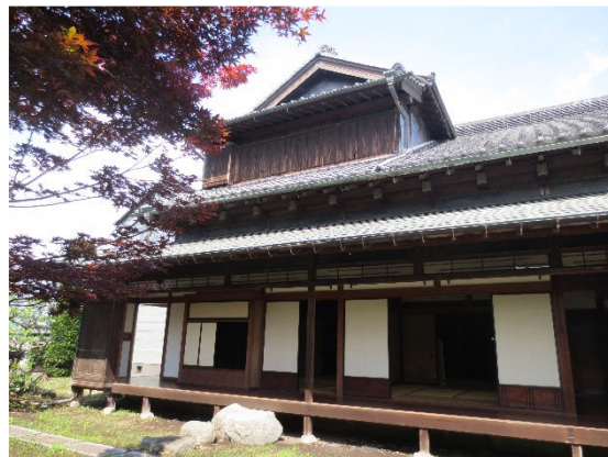
主屋一階 西側廊下
