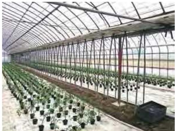
柱が途切れている部分は強度が弱く柱による補強がなされていた。
