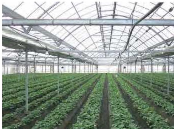
いちごハウスには十分な角形鋼管(□-50×50)による水平ばかりが入っている。
