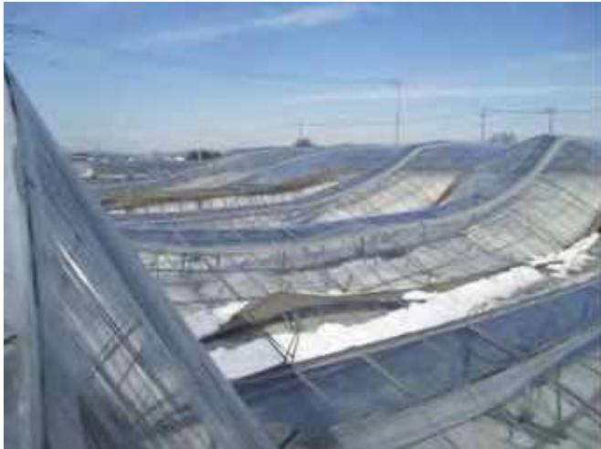
積雪荷重で柱から倒壊したハウス。トマト収穫が始まったばかりだった。
