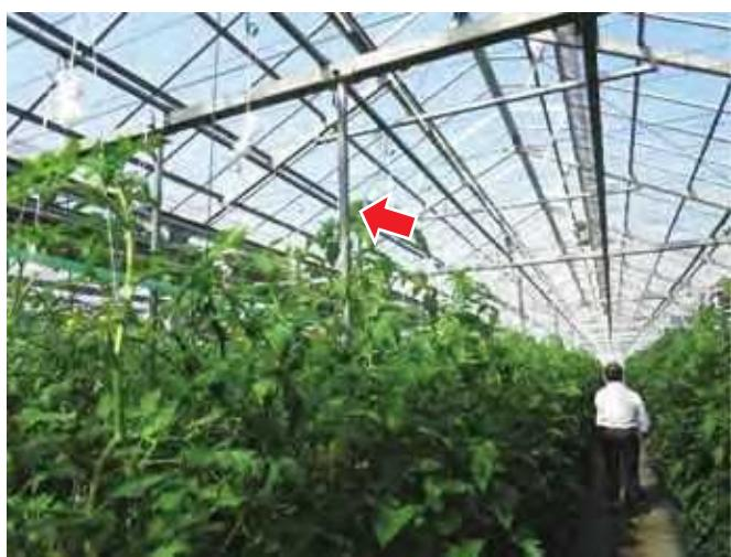
作物荷重がかかるため水平ばかりに中柱を3mおきに設置した例。
