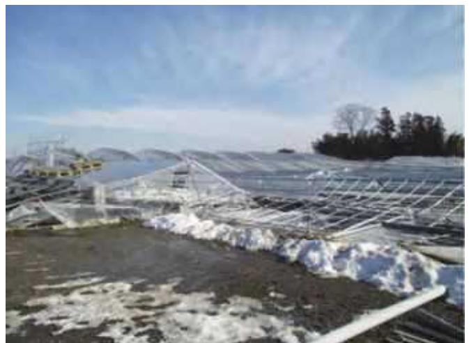
明け方の強風で、基礎のベースプレートから破断し横倒しになった。
