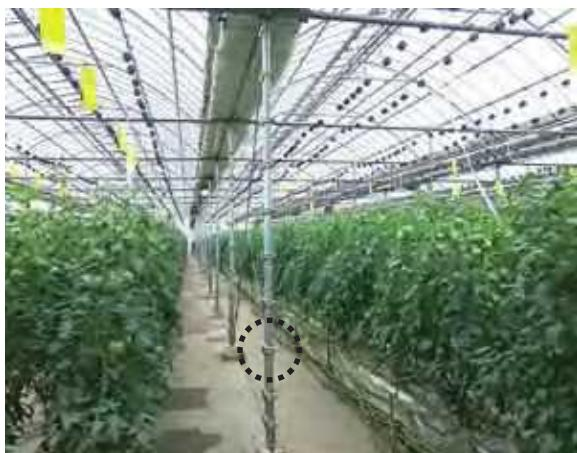
既存の柱に補強のためのパイプがクランプで固定されている。
