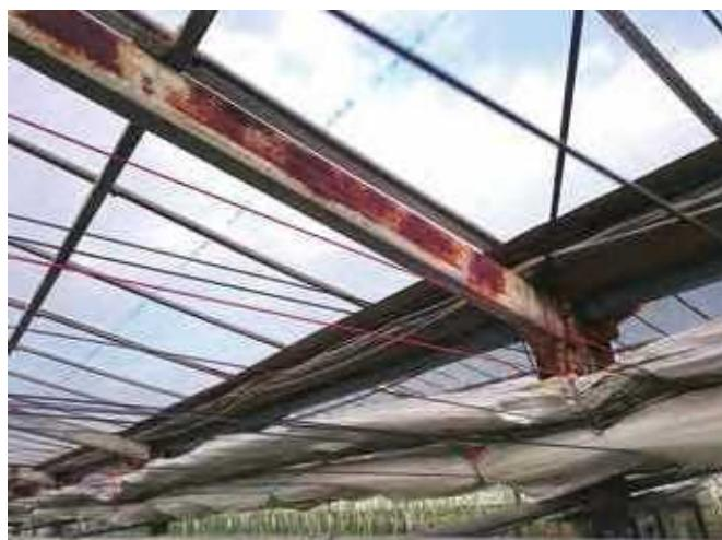
主骨材にサビが生じているため、サビを落とし塗装が必要。
