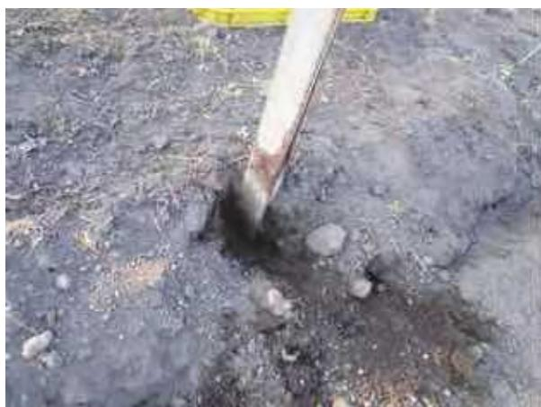
柱と基礎の接合部分が埋没し、柱に著しいサビが生じていた。
