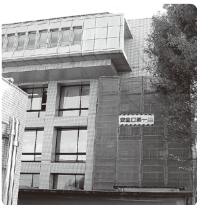
工事中の町庁舎 (外観)
