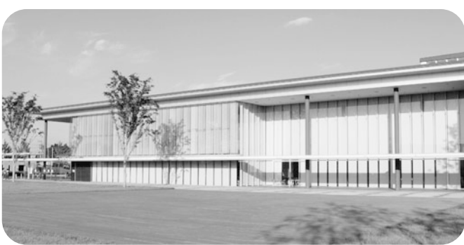
上三川いきいきプラザウッドデッキ
