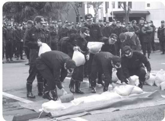
土嚢による水防工法の訓練
