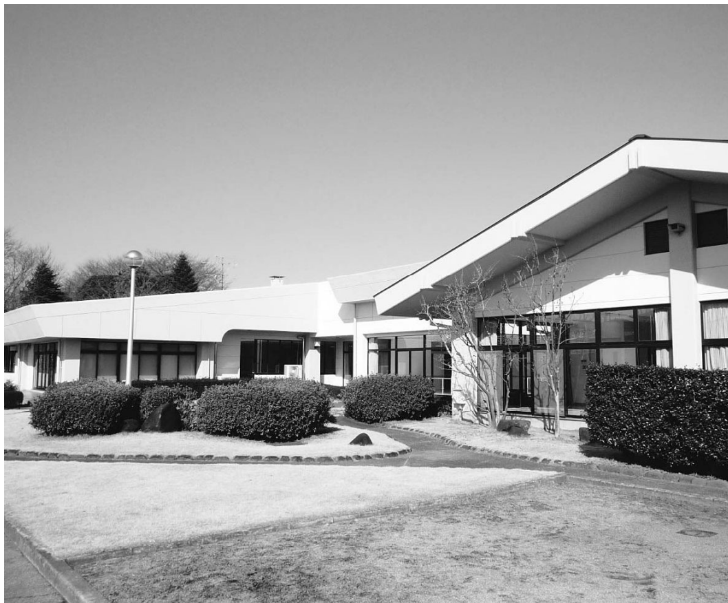
改修工事が完了した旧老人福祉センター
