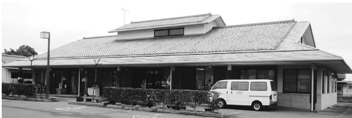
今年秋ごろ改修工事する旧福祉作業所
