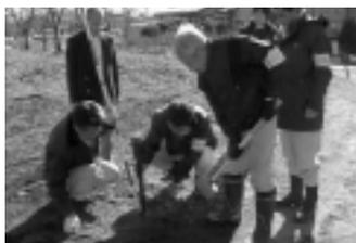
④境界点に接している地権者全員で、境界点の確認をしている様子。地権者全員で間違いないと判断できた場所であれば、その点を確認し、杭を埋設します。
