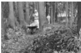
③境界点の位置を確認する作業。道路幅を公図幅で確保した後は、隣地との境界を確認(現地調査前に両地権者同士で確認できているとスムーズに進みます。)
