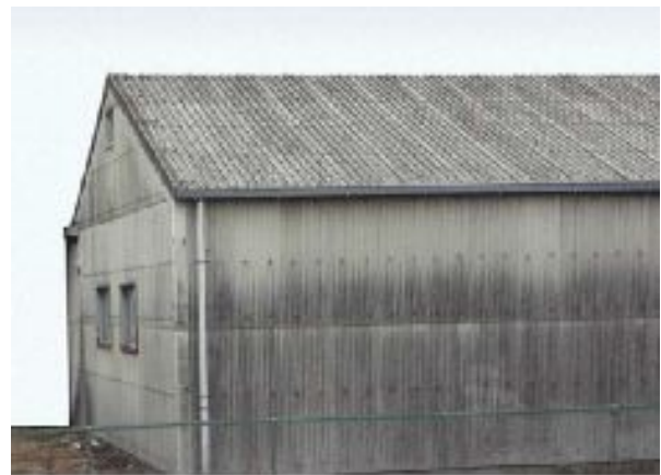
石綿含有スレート波板（屋根・外壁）
