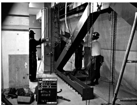
耐震補強工事
