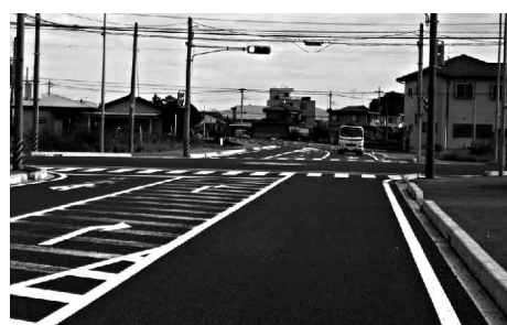
富士山地区の新設道路
